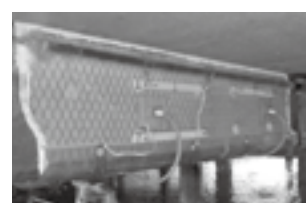
リペアカーテンの適用状況 (海上栈橋) ▶P.13
